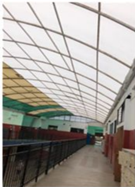
Techo "Policarbonato en patio central
